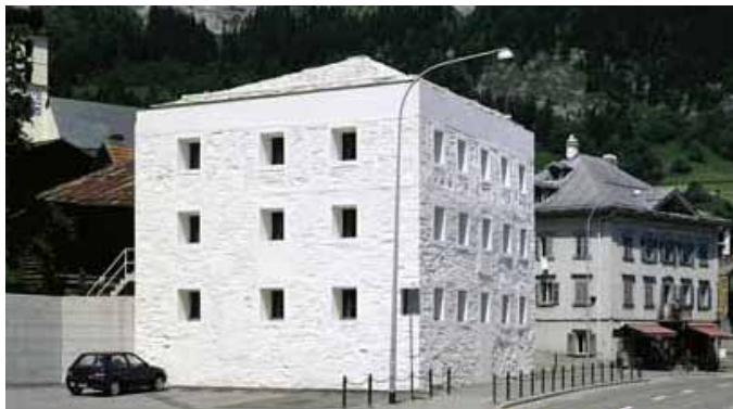
Renovering af bygning som efter at have stået tom i 22 år nu er et museum (Das gelbe Haus i Flims, Schweiz).
