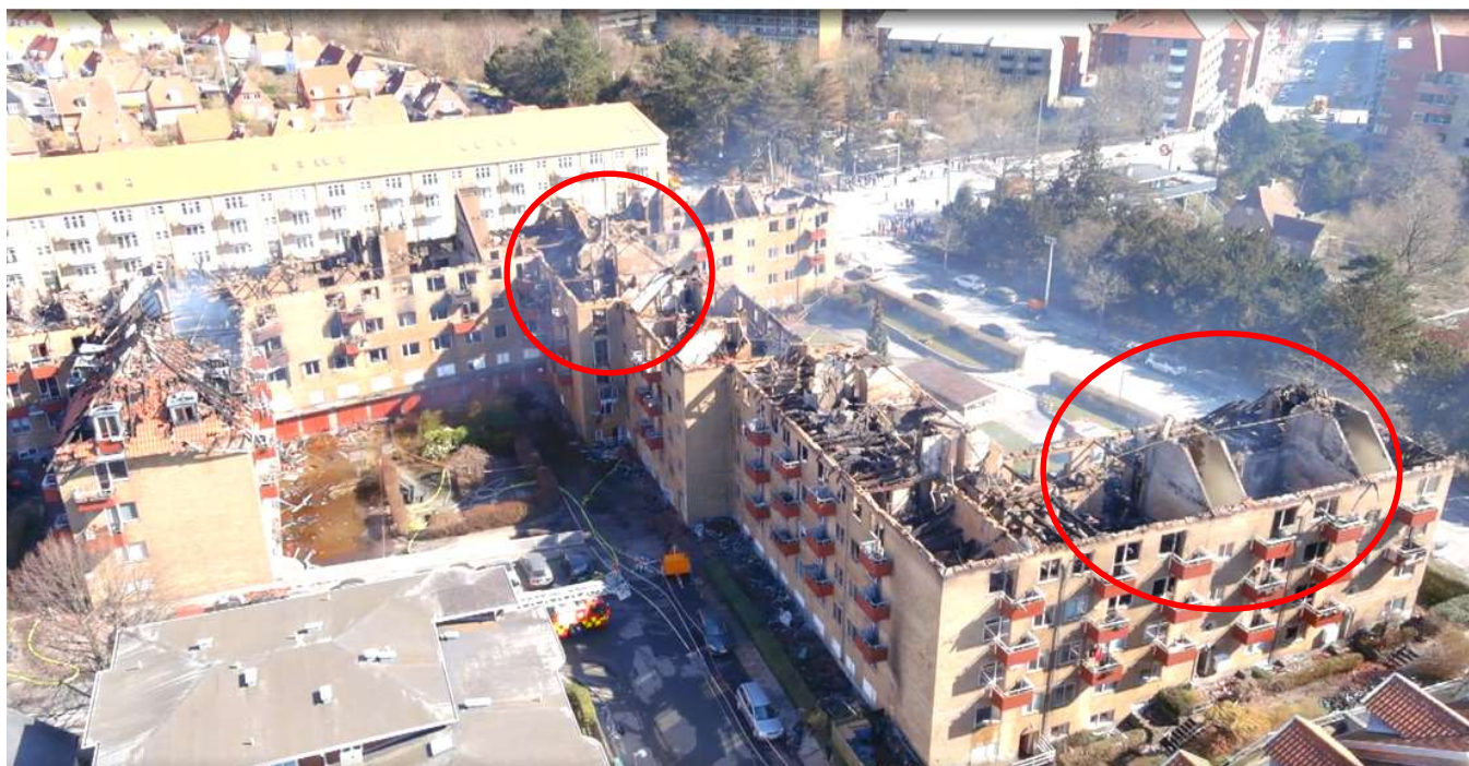
Figur 19 EF Grøndalpark - Billede af TV2 Lorry. De røde markeringer viser områder, hvor branden har spredt sig flere etager nedad.
